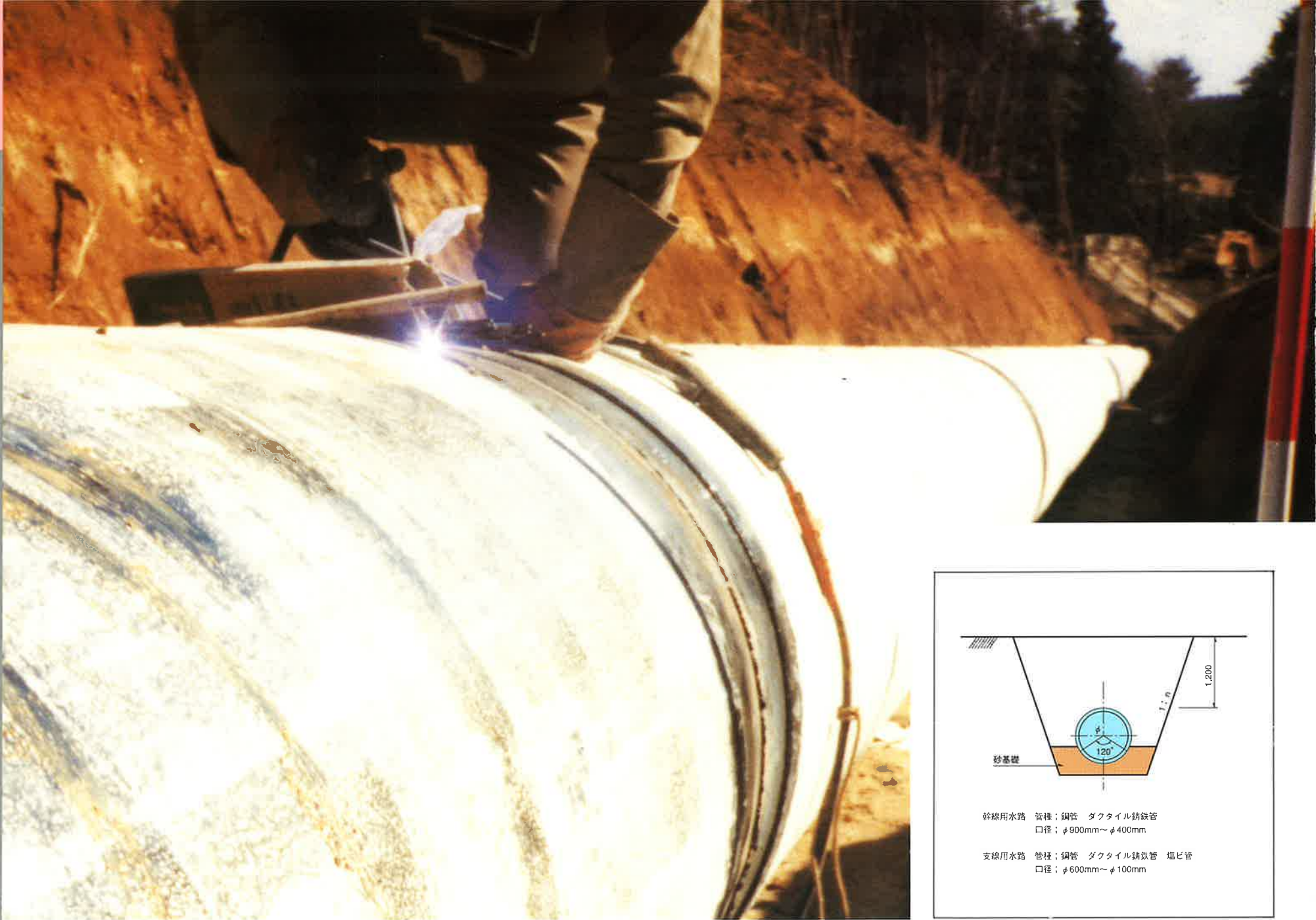
幹線用水路 鋼管溶接
